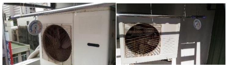
冷氣出風口 A B 區
